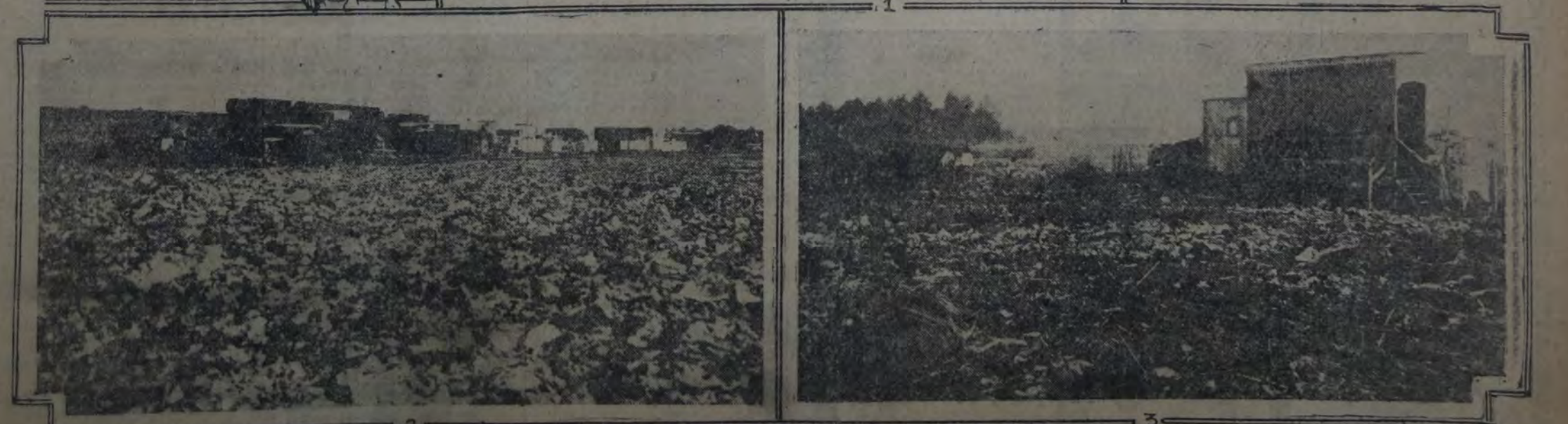
1 y 2. — Aspectos que ofrecen los terrenos rellenos con residuos en Avenida Cruz y Centenera. Barrio eminentemente obrero, esta zona va poblándose con rapidez, los innumerables vecinos no sólo carecen de luz, de desagües, de caminos transitables, sino que han de soportar el sucio espectáculo de esos terrenos, exponiéndose a sufrir las consecuencias de cualquier epidemia. — 3. En otra zona de Nueva Pompeya, calle Beasley a la altura del 3700.
